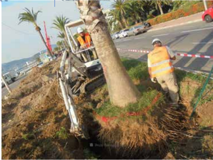
... pour pouvoir les découper à la disceuse, et dégager un pourtour bien conique.
