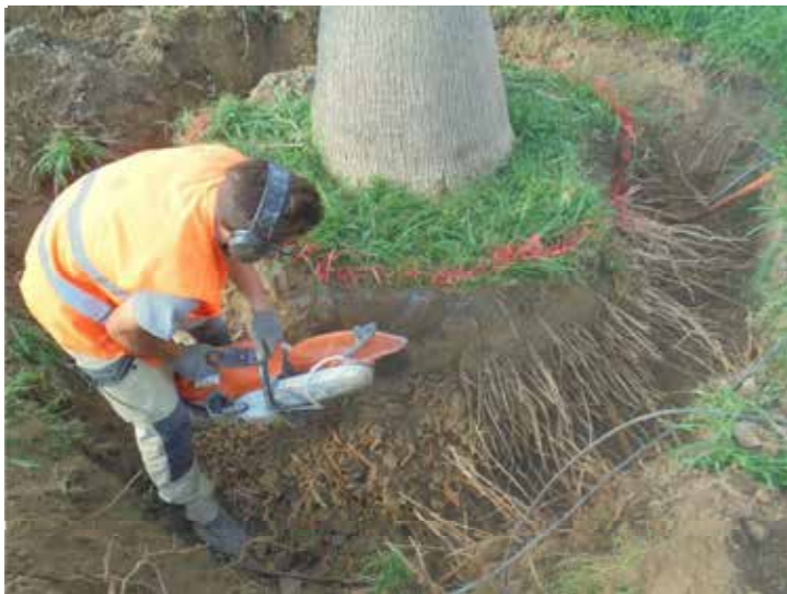
Des planches sont assemblées tout autour et jointes avec un ruban d'acier ou « feuillard ».
