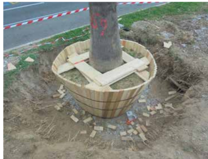
L'arbre est couché, puis les racines inférieures sont coupées. Le fond du bac est ensuite fabriqué, également avec des planches.
