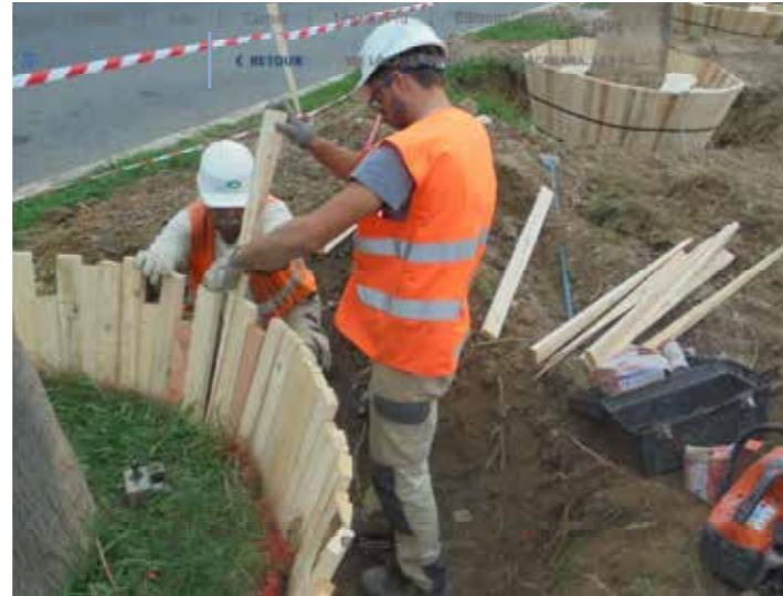
Des cales sont installées dans le bac, dont le bord supérieur est aligné à niveau égal.
