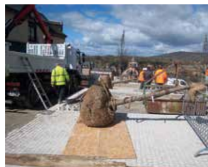
Les féviers de force 30/35 ont nécessité le creusement d'une fosse de plantation d'environ 10m³. Les mottes ont été ancrées dans le sol pour éviter d'utiliser des tuteurs.
