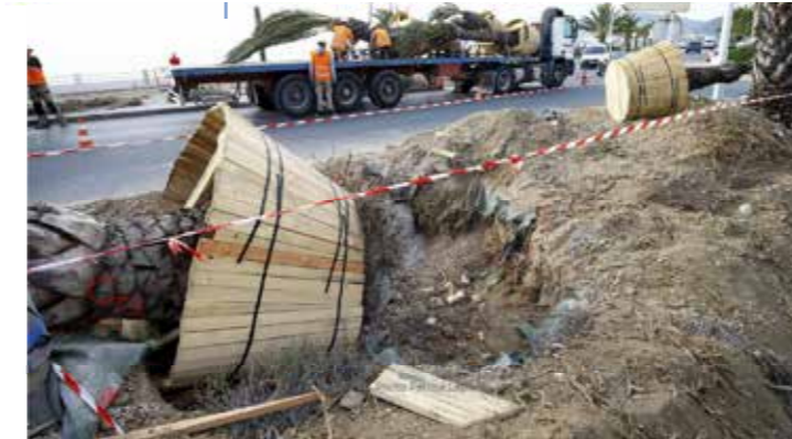
Une sangle est attachée autour du tronc pour charger l'arbre à la grue.
