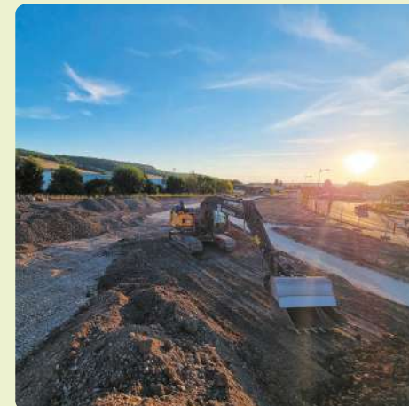
↑ Revitalisation des sols, France
