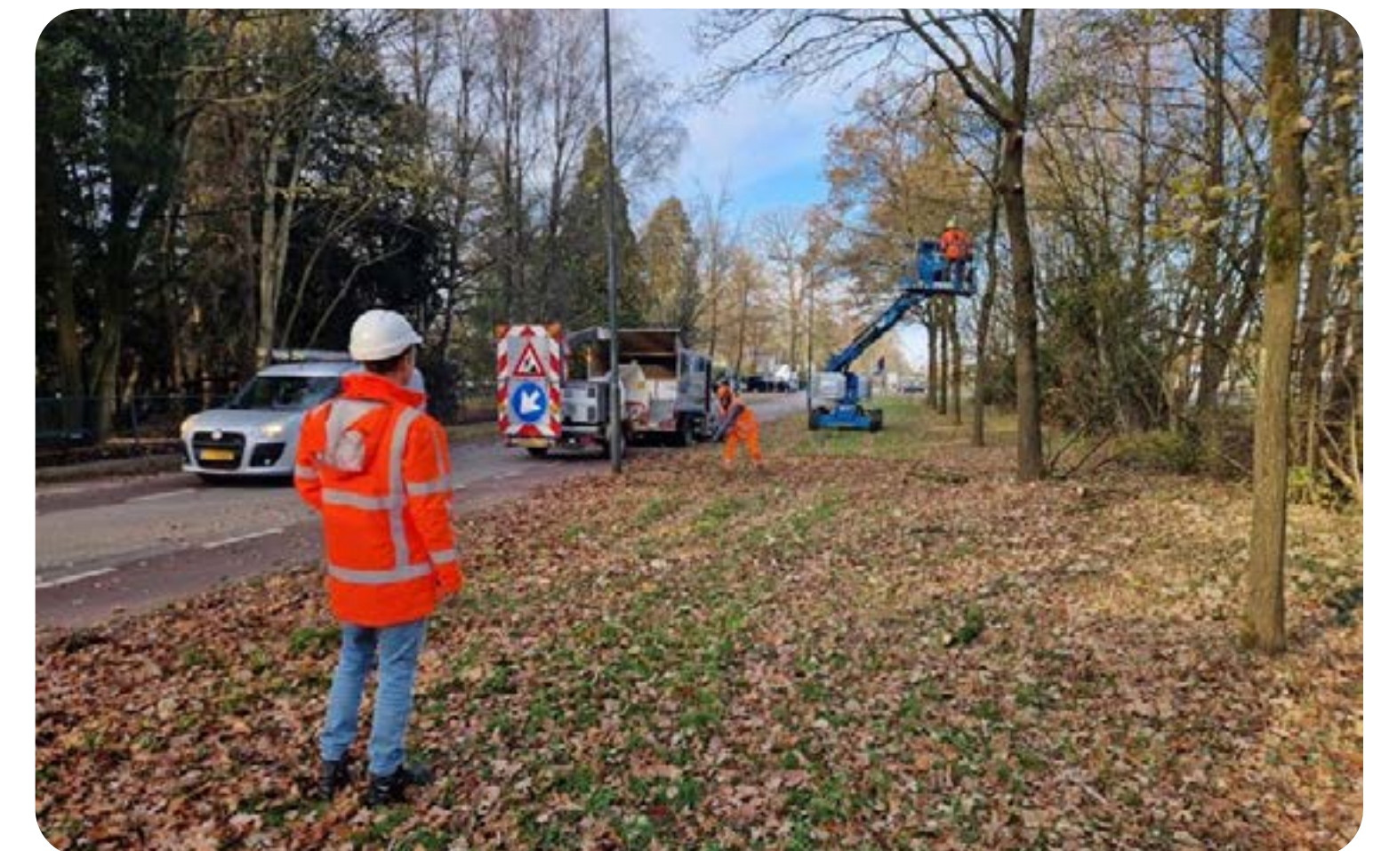
Travaux arboricoles sur plateforme élévatrice mobile, NL
